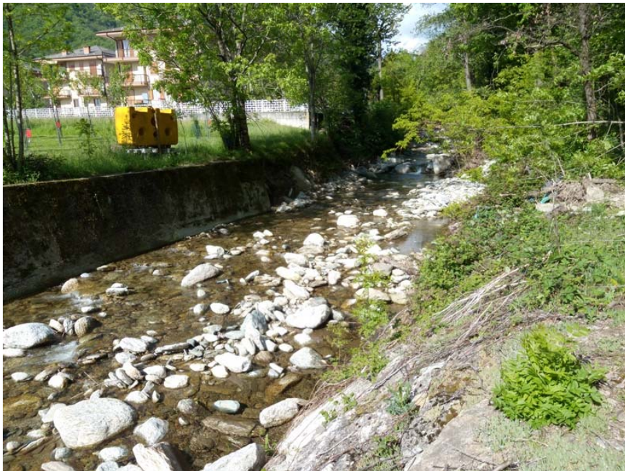
Figura 2.2.2: alveo del torrente Agliasco a monte dell'area di intervento.
