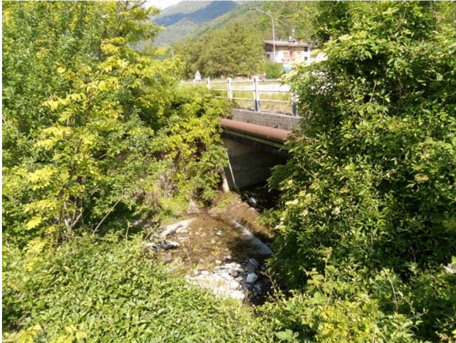
Figura 2.2.8: attraversamento della S.P. 26 sullo scolmatore e sottoservizi presenti.
