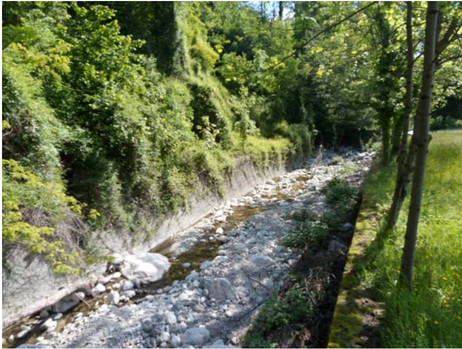
Figura 2.2.1: alveo del torrente Agliasco a valle dell'area di intervento.
