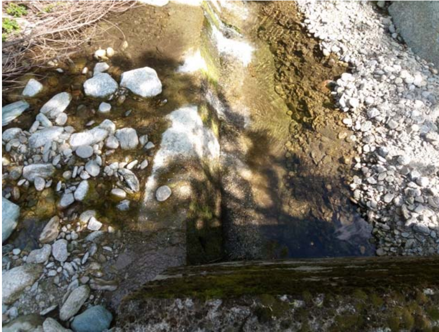
Figura 3: briglia in c.a. sul torrente Agliasco immediatamente a valle dell'are di intervento.
