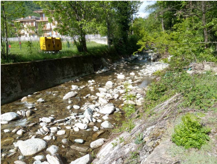
Figura 2: alveo del torrente Agliasco a monte dell'area di intervento.
