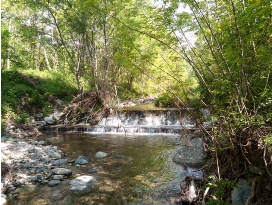
Figura 6: briglia in calcestruzzo a valle della provinciale (non oggetto di intervento).
