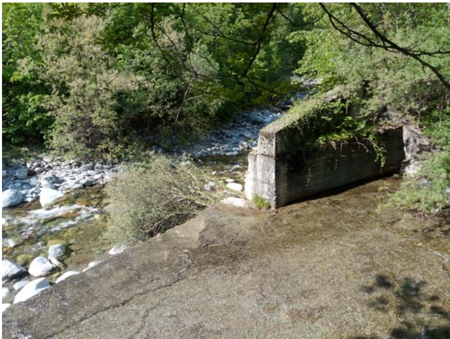
Figura 7: manufatto in c.a. di scarico dello scolmatore nel Fiume Po (non oggetto di intervento).
