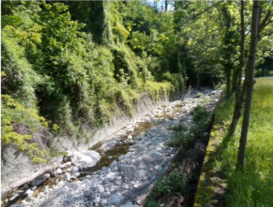
Figura 1: alveo del torrente Agliasco a valle dell'area di intervento.
