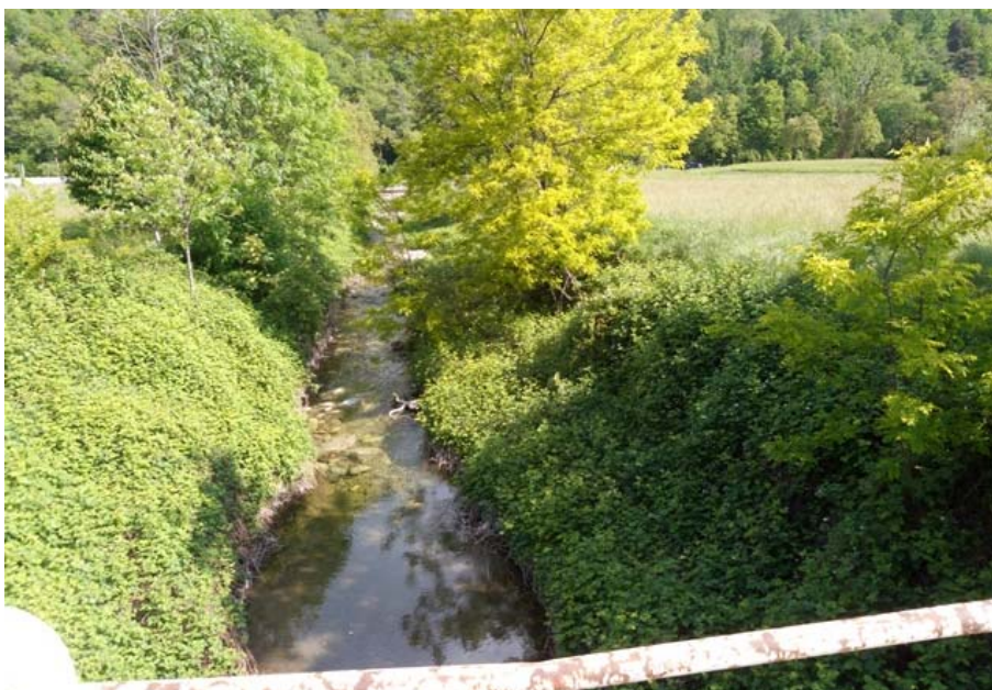
Figura 5: alveo dello scolmatore a valle dell'attraversamento della Provinciale.
