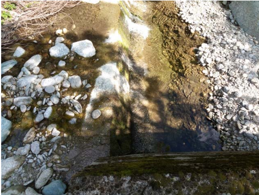
Figura 4: briglia in c.a. sul torrente Agliasco.
