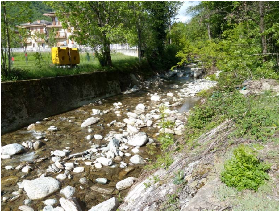
Figura 3: alveo del torrente Agliasco a monte dell'area di intervento.
