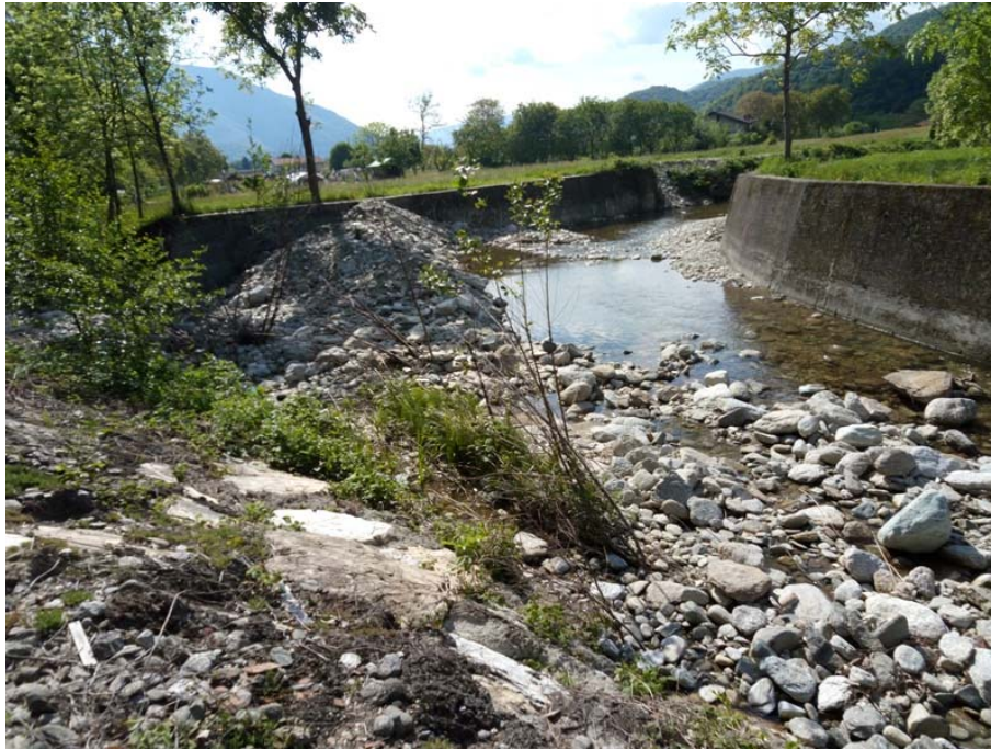
Figura 10: sbarramento in materiale sciolto provvisorio.
